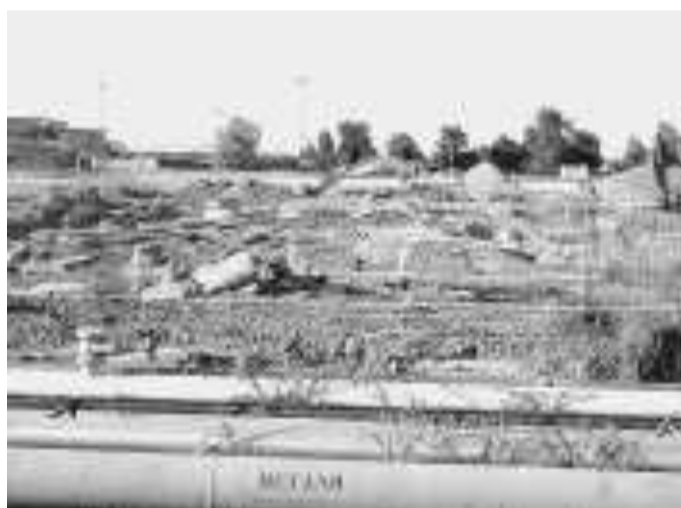
Sbancamenti nell'area del petrolchimico
