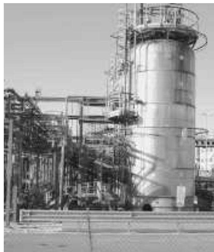
Un impianto al petrolchimico di Ferrara
